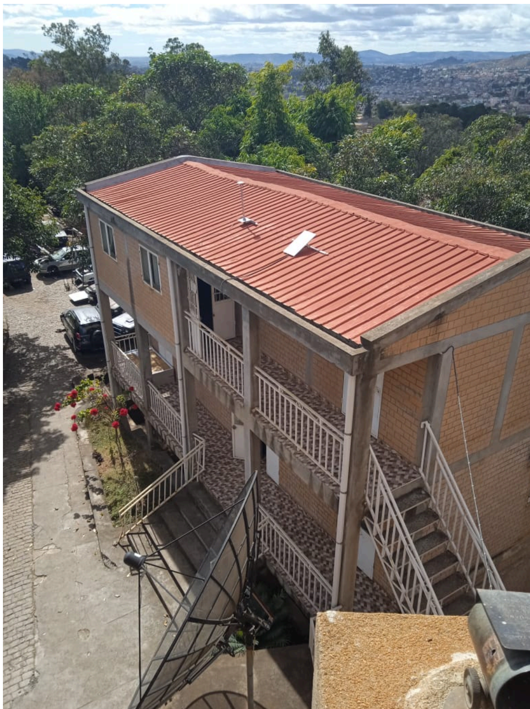
FIGURE 1.3 – Antenne centipede et antenne Starlink posées sur le toit de la salle informatique de l'IOGA.
